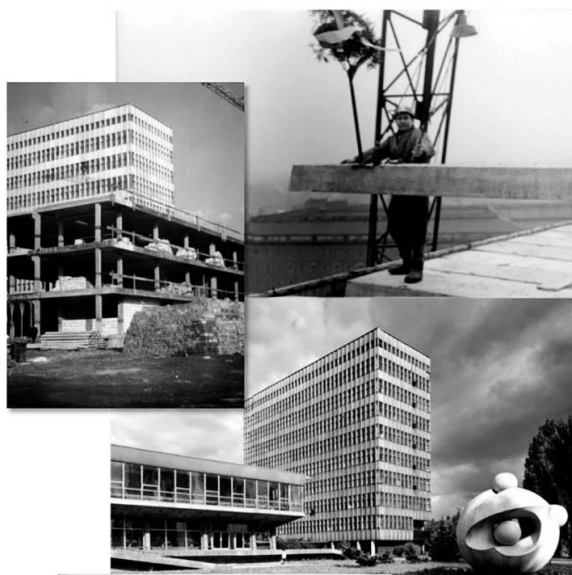
Фото 9. Будівництво Інституту хімії у Вроцлаві
