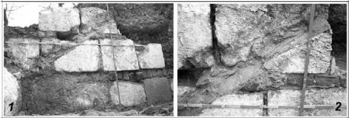
Рис. 9. Частина північного лиця муру 15: 1 – система мурування; 2 – сліди біжучого склепіння Fig. 9. Part of the north face of the wall 15: 1 – system of construction; 2 – traces of the vault
