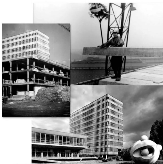
Фото 9. Будівництво Інституту хімії у Вроцлаві
