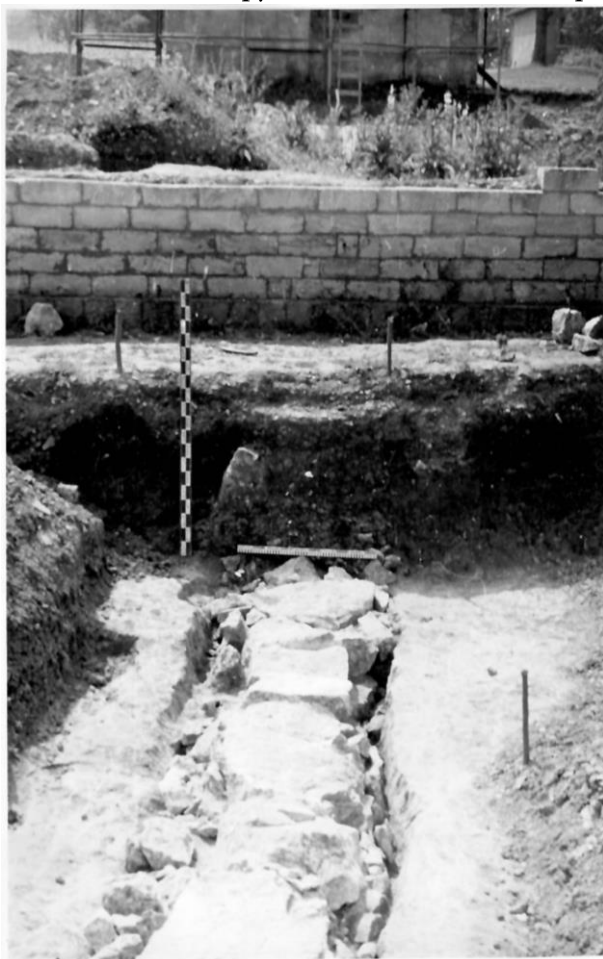
Рис. 12. Положення західного водовідвідного каналу в рові (фото В. Ауліха)
