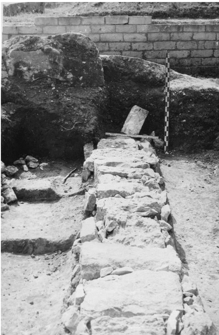
Рис. 11. Вид з північного боку частини східного водовідвідного каналу, зруйнованого реставраційними роботами біля північної стіни Успенського собору (фото В. Ауліха)
